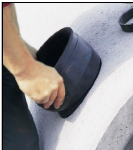
rechts: Einsetzen des Anschlussstutzens
