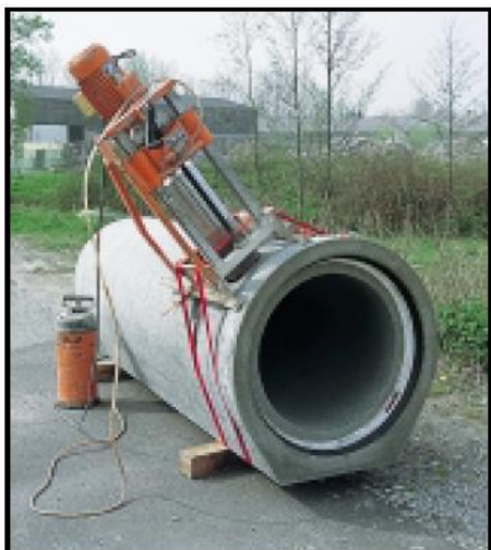
links: Anbohren des FBS-Rohres Bild 2.19: Einbau eines Anschlussstutzens für einen Abzweig
